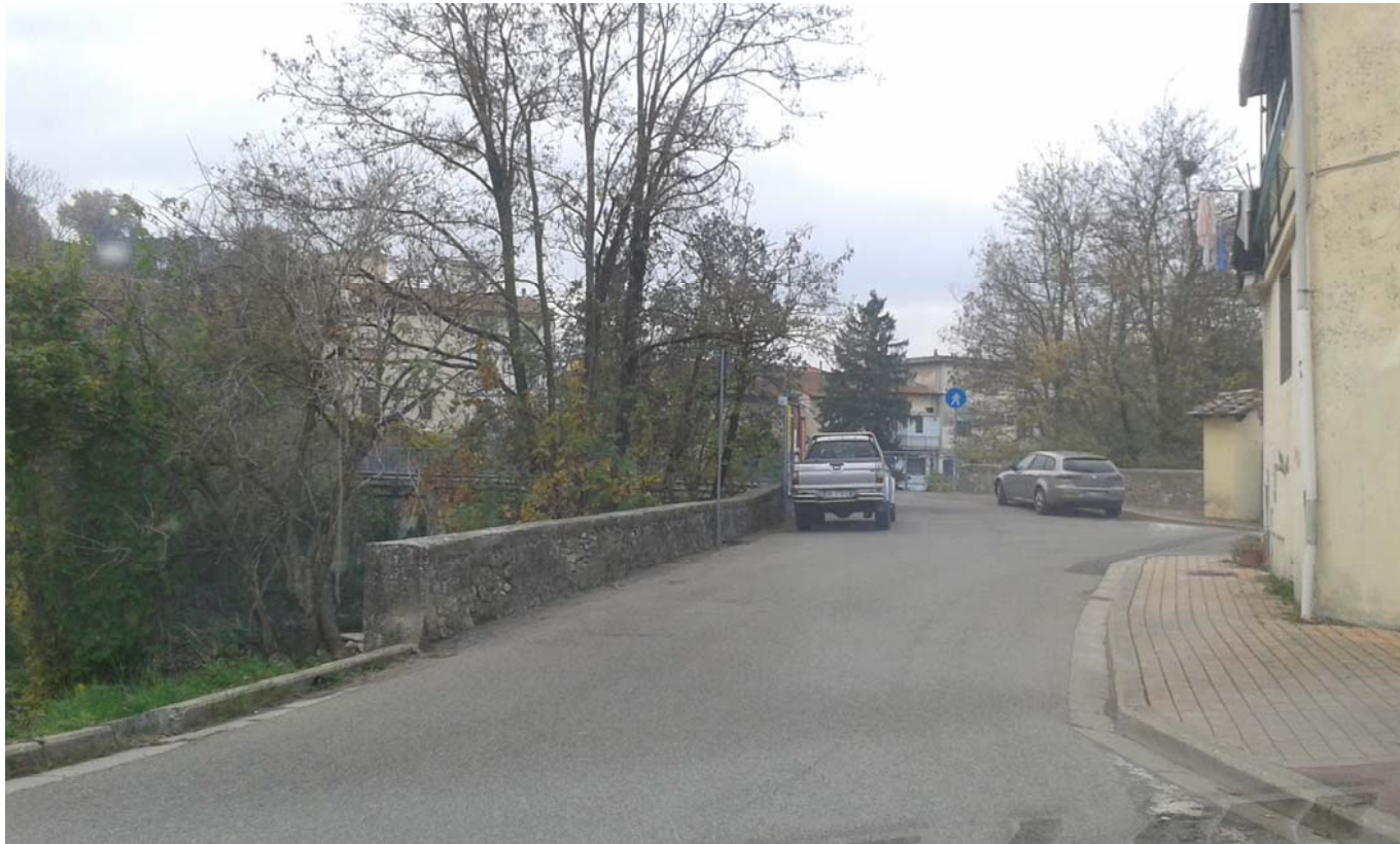
VIA CARDETOLE – ZONA PONTE PEDONALE FIUME CARZA
