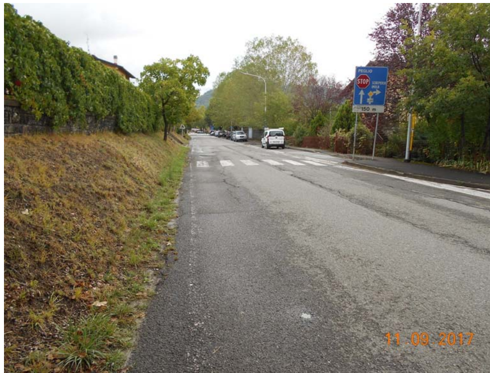
PARTICOLARE DETERIORAMENTO MANTO
