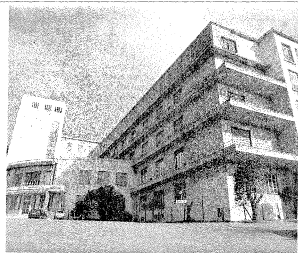
RINASCITA L'ex ospedale Banti. In base al protocollo firmato da Asl, Comune e Regione, ospiterà una Rsa e una piastra dei servizi
