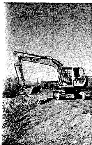
Lavori di manutenzione su un argine
